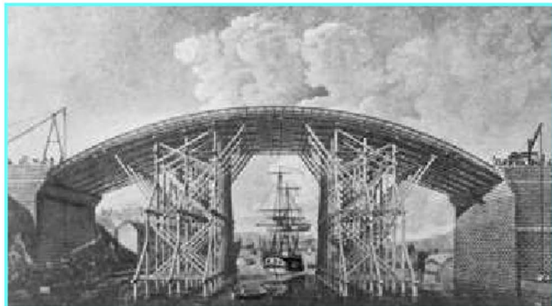
Мост на реке Уир, около Сандерленда, построенный в 1796 г. В Англии с последних лет XVIII в. железо начинает замещать дерево
